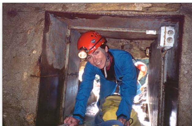
Photo 41 : Porte de l'entrée 2 munie d'un système d'alarme
